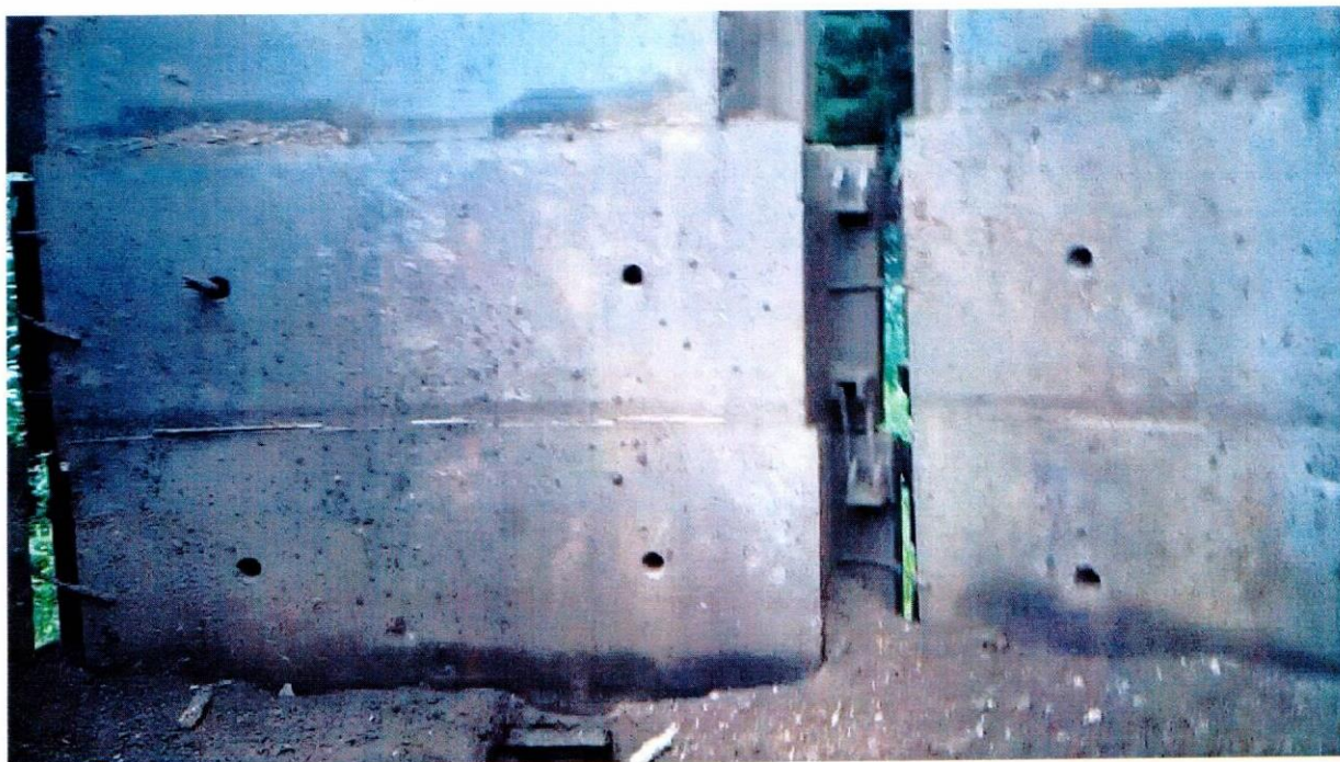
Рисунок 15 – Бетонные блоки, ограничивающие взрывной стенд
